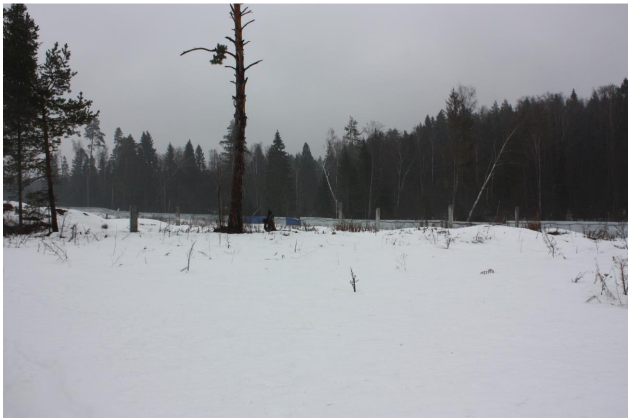
Рис. 3.1.2. Общий вид свай секции 1-2
