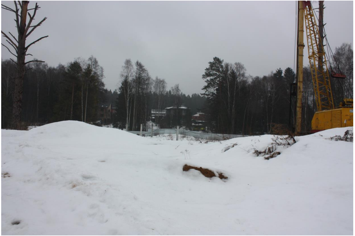
Рис. 3.1.1. Общий вид свай секции 1-2
